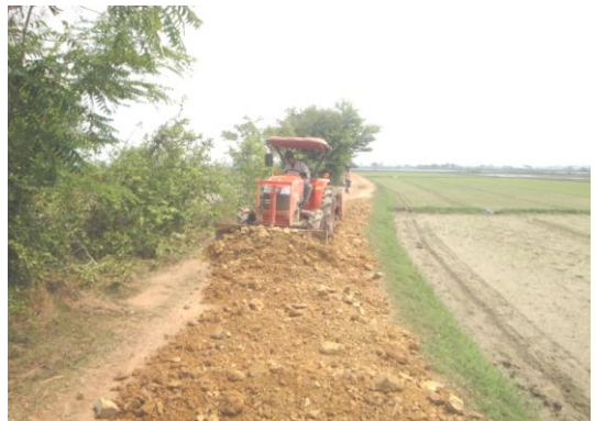
โครงการก่อสร้างถนนลูกรังสายทางหลวง เชื่อมหมู่ที่ ๑, ๒ วัดแก้วฟ้าหมู่ที่ ๖
