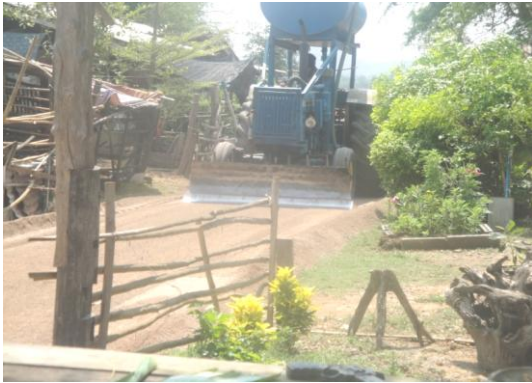
โครงการซ่อมแซมถนนลงหินคลุก พร้อมเกลี่ยเรียบ หมู่ที่ ๑ - ๑๑
