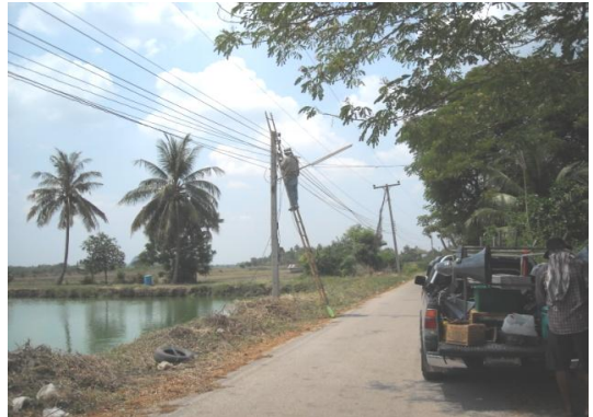
โครงการติดตั้ง / ปรับปรุงเสียงตามสาย บ้านโคกกระต่าย หมู่ที่ ๒
