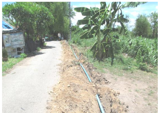
โครงการขยายท่อเมนประปาหมู่บ้านพร้อมติดตั้ง เครื่องชั้บเมิรส์ หมู่ที่ ๑๐
